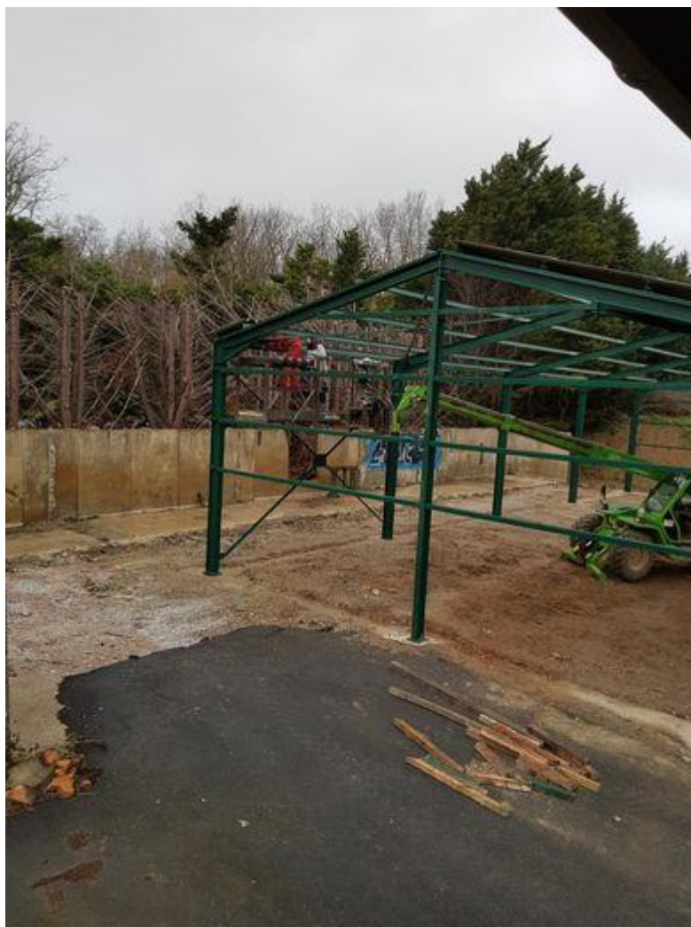
Construction du hangar
